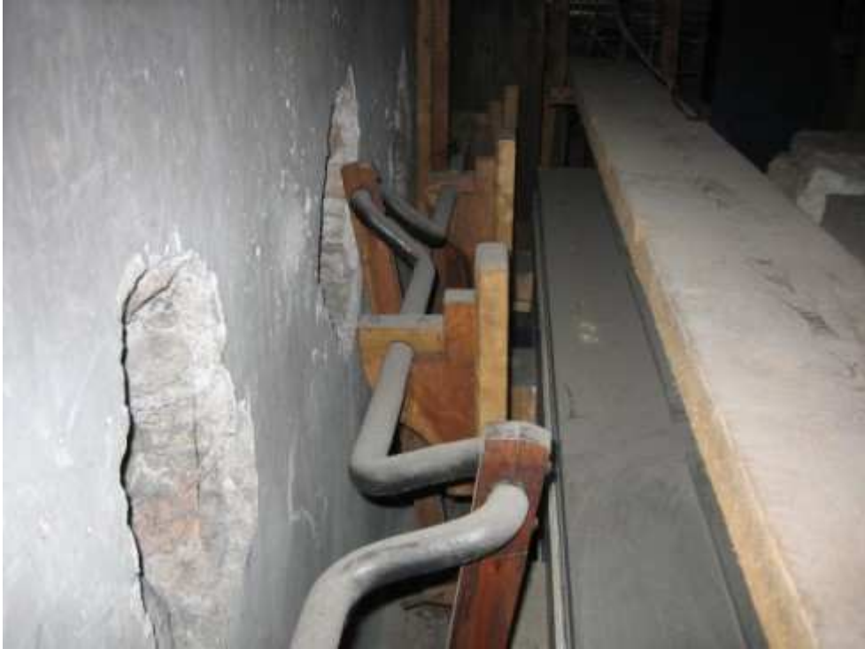
Il sistema di caricamento manuale dei mantici con albero a collo d'oca
